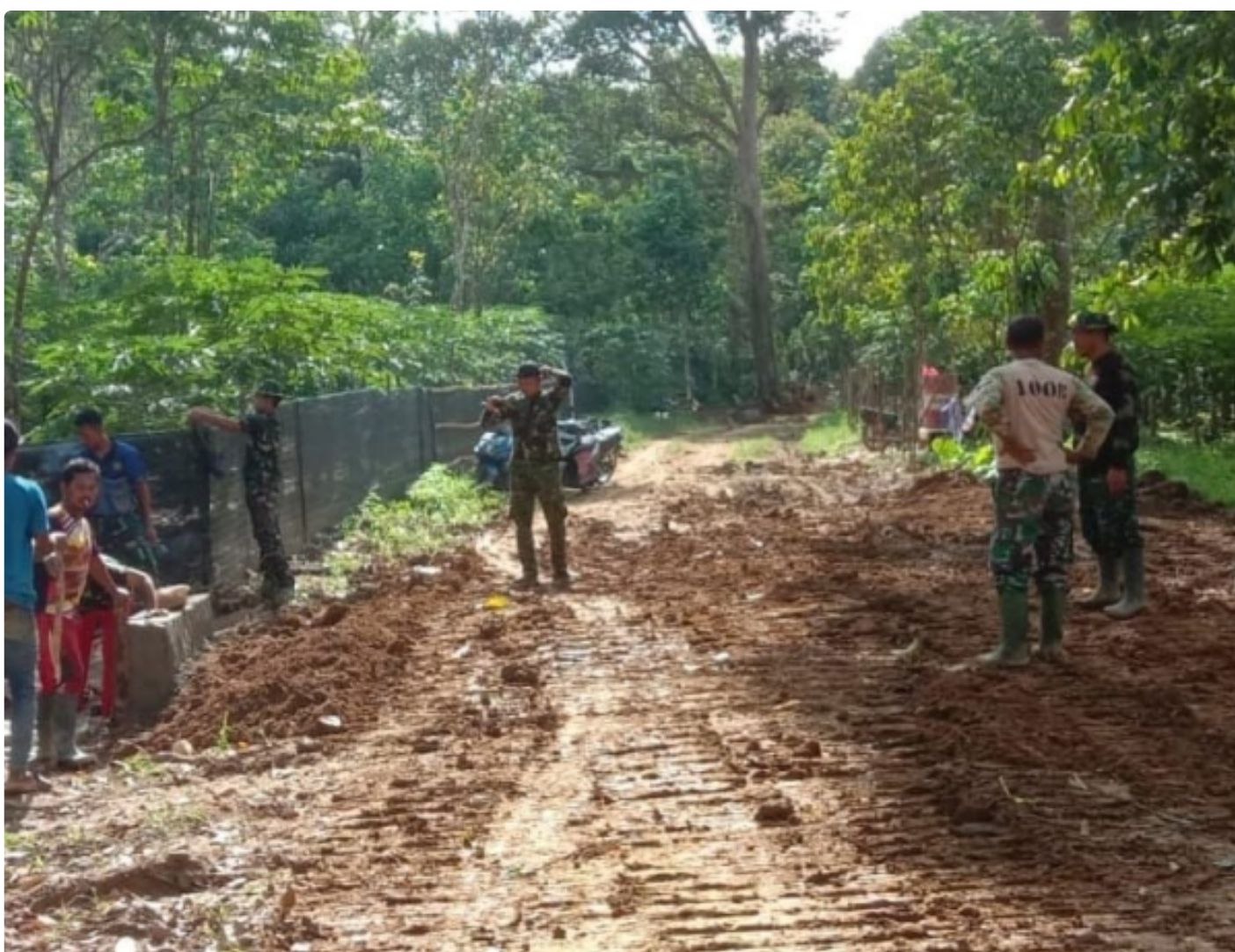
5 Titik Gorong-Gorong Akan dipasang di Lokasi TMMD Ke-115 Kodim 1008/Tabalong
