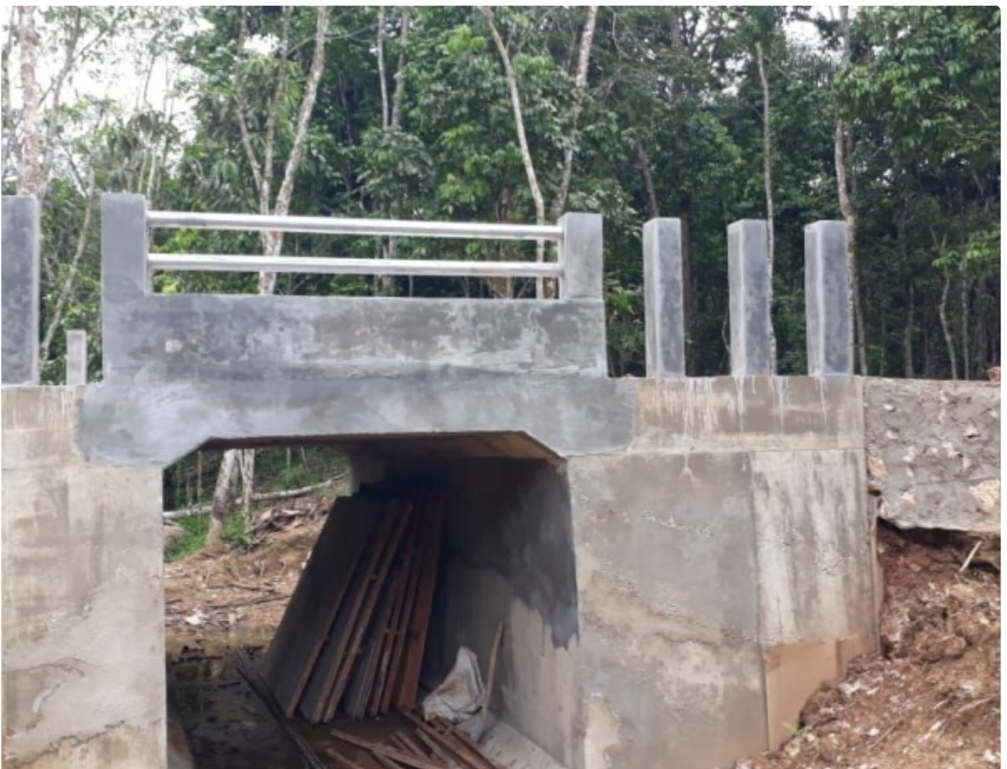
Jembatan Box Culvert Masuk Tahap Finishing
