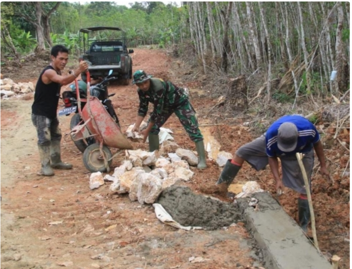
Pembuatan Badan Jalan Sepanjang 1020 meter Capai 45 Persen
